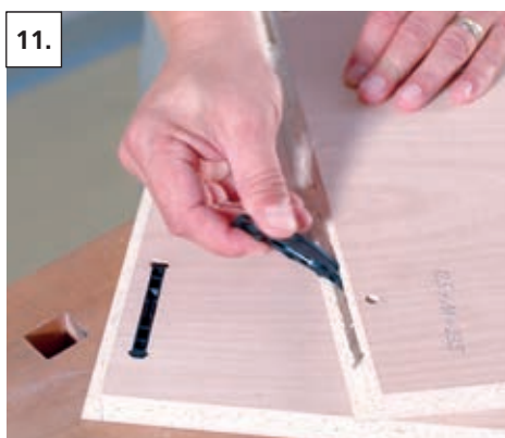
11. Insérer les deux parties du Clamex P sans outil
